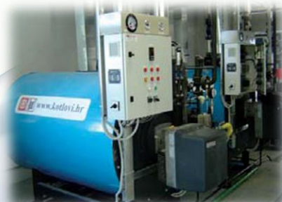
DUBROVAČKI VRTOVI SUNCA 2 x VPS 600 2 x 600 kg/hr steam
